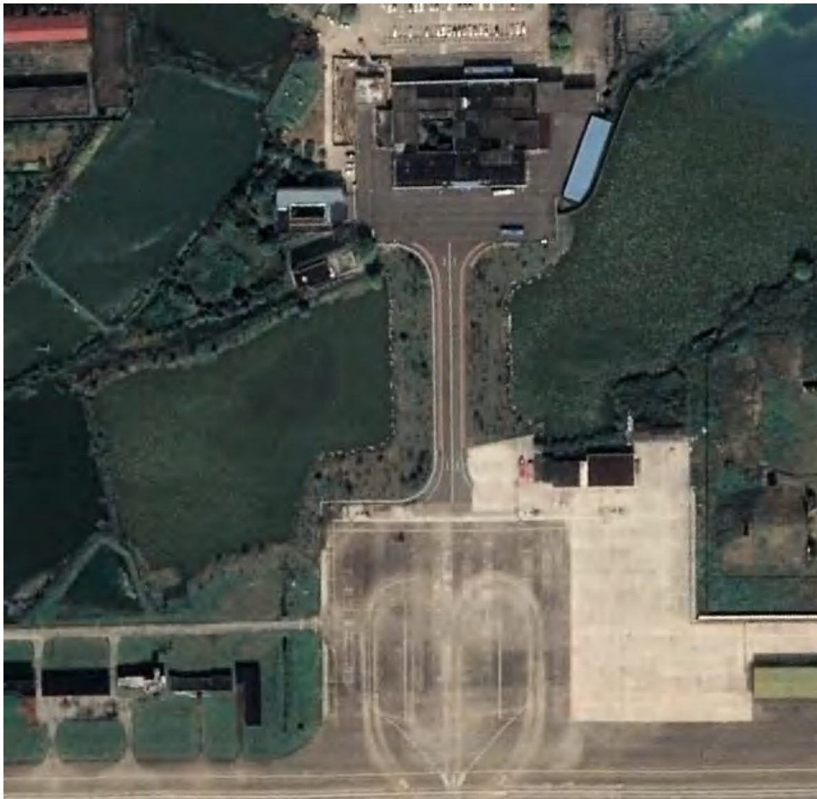
图 4.2-2 衢州机场民航站坪现状
