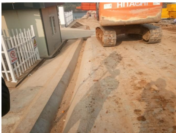
图 1 施工场地临时排水沟
