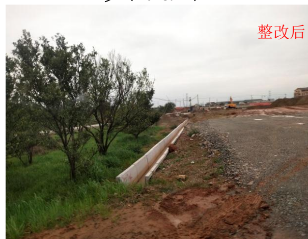
图 1-83 排水沟内淤积物清理 (2018.12)
