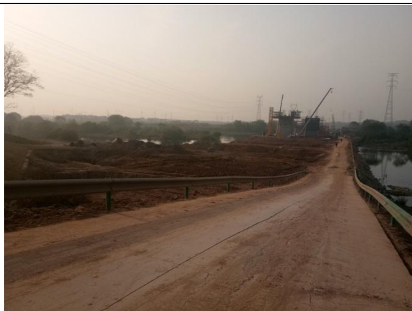
图 1-11 坑西特大桥施工便道现状 (2017年11月)
