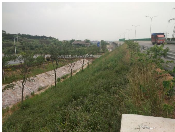
图 1-65 下缪大桥桥头锥坡绿化 (2020.5)
