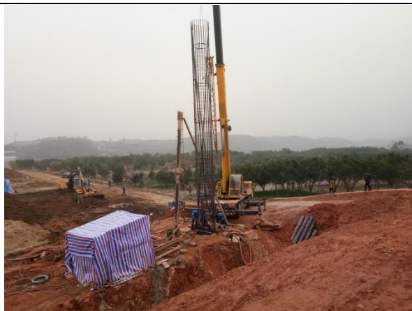
图 1-17 下缪大桥施工现状 (2018 年 2 月)
