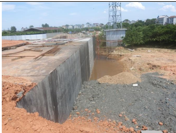
图 1-23 寺落潭桥施工现状 (2018.5)
