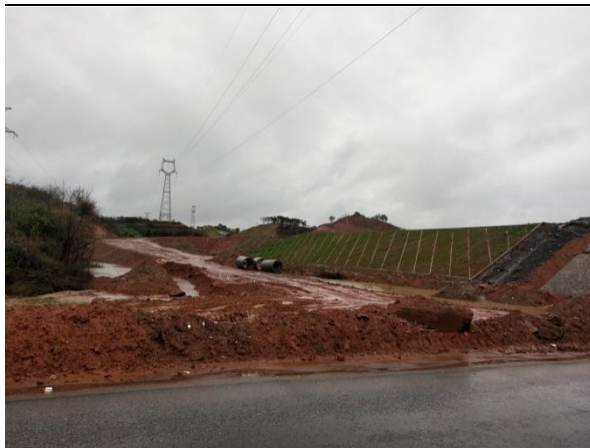
图 1-40 路堤边坡框格植草现状 (2019.2)
