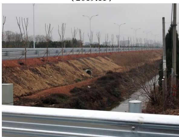
图 1-63 土路肩和路堤边坡绿化 (2020.1)
