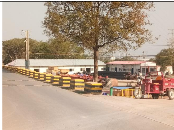
图 1-6 施工场地硬化
