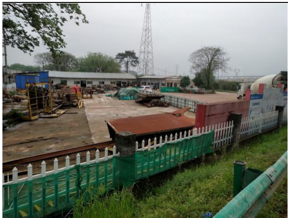
图 1-46 施工场地现状 (2019.5)
