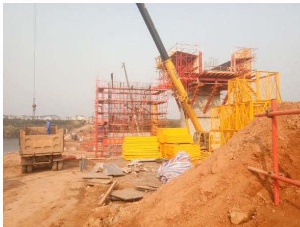
图 1-9 下缪大桥施工现状（2017.10）
