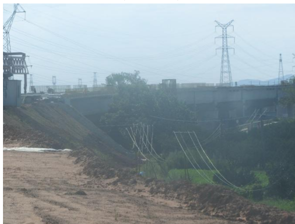
图 1-27 路基两侧开挖临时排水沟 (2018.7)
