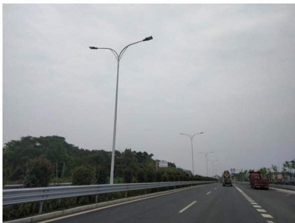
图 1-64 中央分隔带综合绿化现状 (2020.5)
