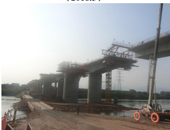
图 1-24 下缪大桥施工现状 (2018.6)
