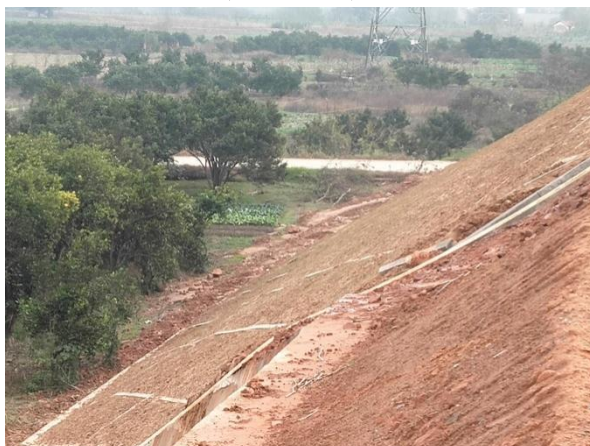
图 1-38 路堤边坡框格植草及急流槽现状 (2019.1)
