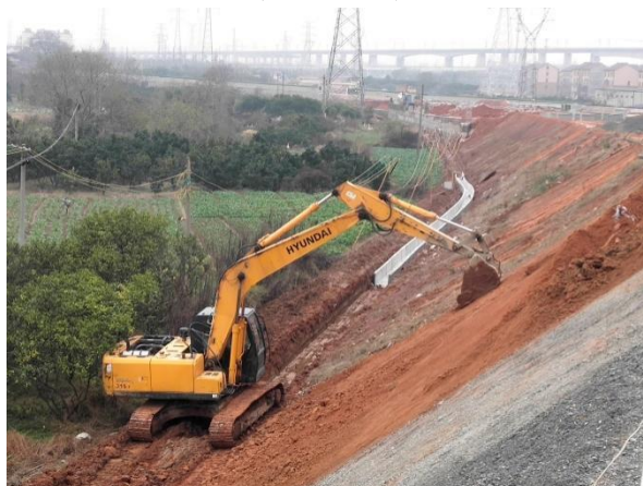
图 1-39 修补雨水冲刷的侵蚀沟 (2019.1)
