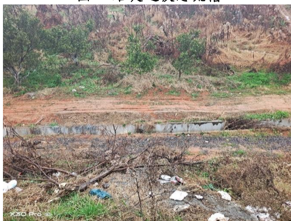
图 6 路堤边坡下方排水沟
