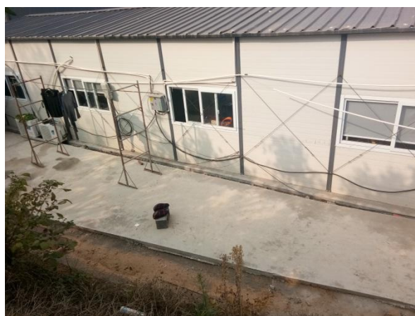
图 2 施工场地临时排水沟
