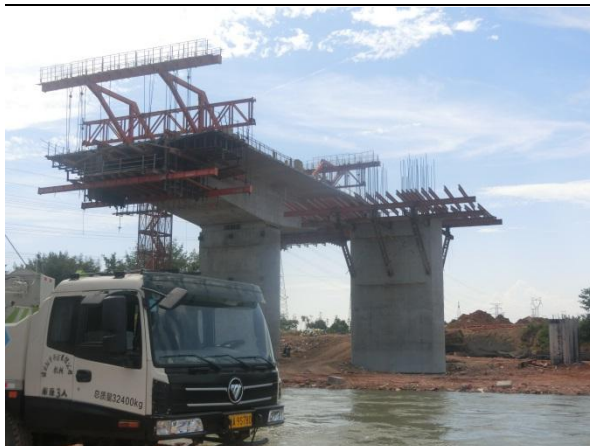
图 1-22 坑西特大桥施工现状 (2018.5)
