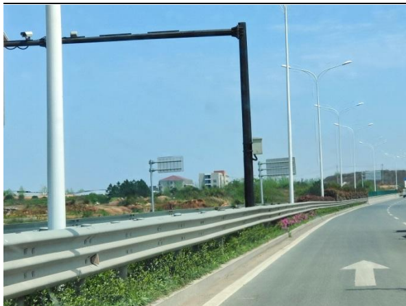
图 1-72 中央分隔带综合绿化 (2021.5)
