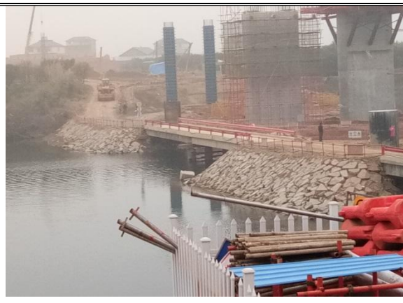
图 1-2 临河侧边坡碎石填筑防护
