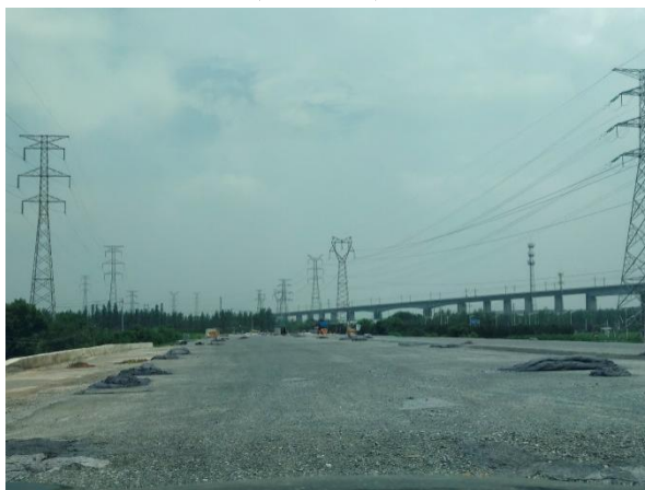
图 1-52 主线路基工程现状 (2019.8)
