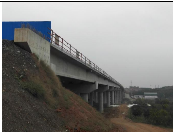
图 1-35 下缪大桥施工现状 (2018.11)
