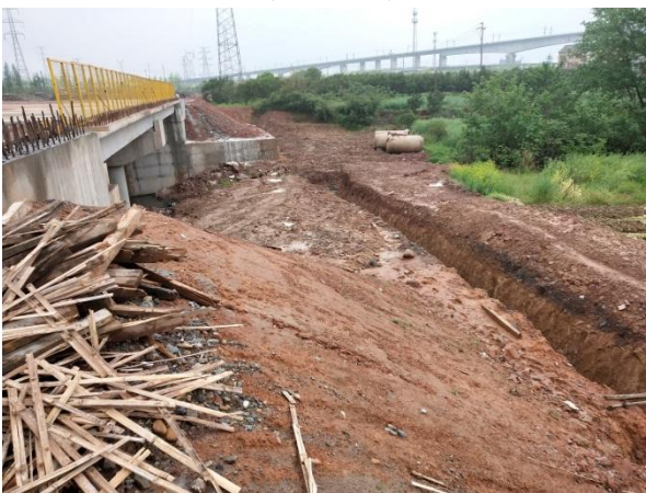
图 1-45 寺落潭桥施工现状 (2019.4)
