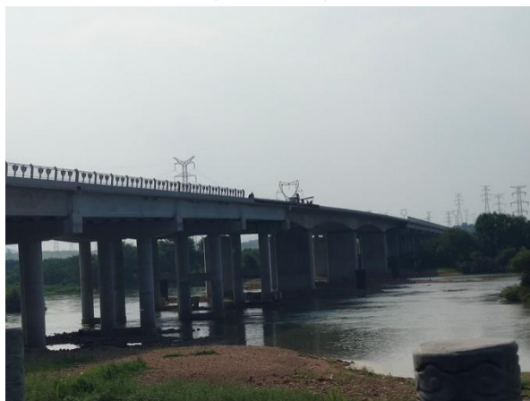
图 1-59 坑西特大桥施工现状 (2019.11)
