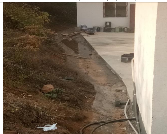
图 1-3 施工场地临时排水沟 2
