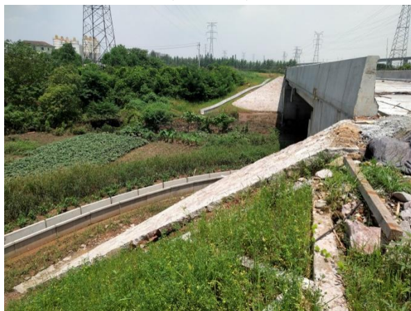
图 1-53 路堑边坡绿化施工现状 (2019.8)
