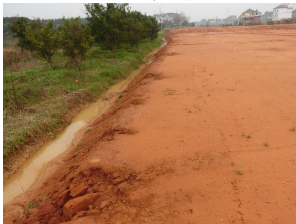
图 1-21 路基两侧临时排水沟 (2018 年 4 月)
