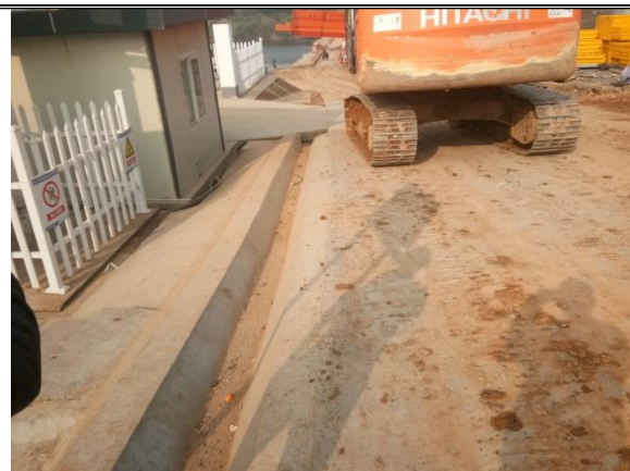
图 1-1 施工场地临时排水沟 1
