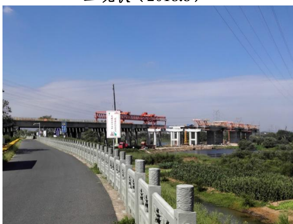
图 1-30 坑西特大桥施工现状（2018.9）
