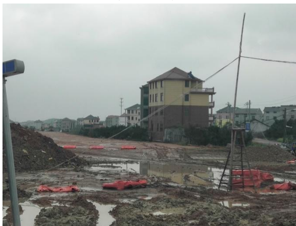
图 1-44 主线路基终点施工现状 (2019.4)
