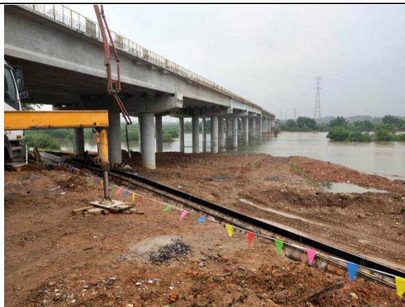
图 1-47 坑西特大桥施工现状 (2019.5)
