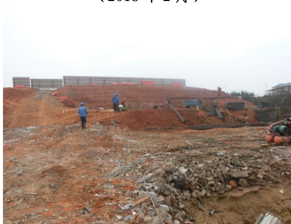
图 1-19 下缪大桥桥台施工现状 (2018 年 3 月)
