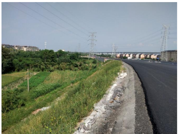
图 1-58 主线路基工程现状 (2019.11)
