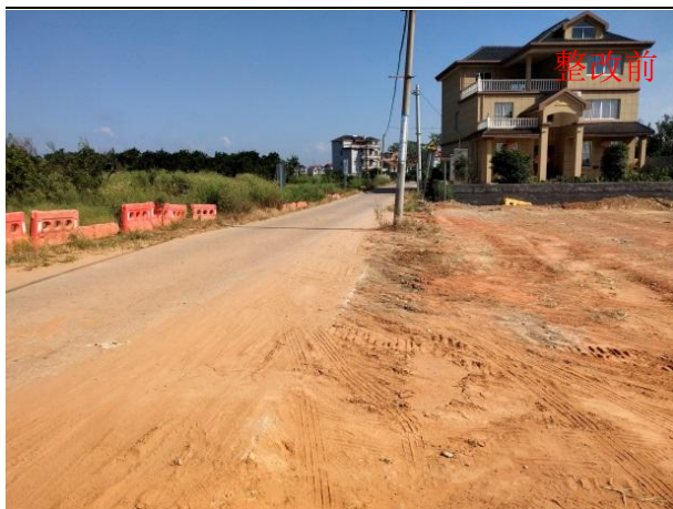
图 1-80 K20+800 平交处有较多的渣土带到工程红线外 (2018.9)
