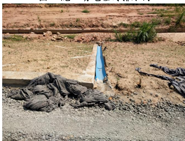
图 4 路堤边坡急流槽
