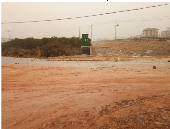
图 1-14 主线路基施工现状 (2018年1月)
