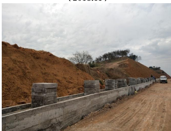
图 1-37 路堑边坡喷薄草籽施工现状 (2018.12)
