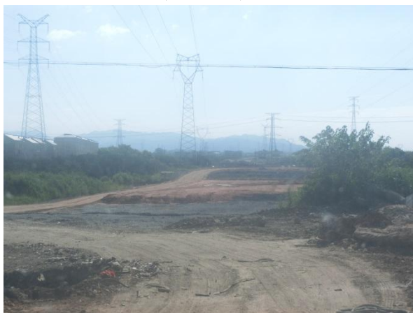
图 1-26 主线路基工程施工现状 (2018.7)
