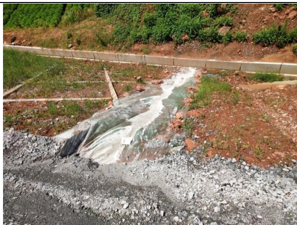
图 1-55 路堑边坡绿化施工现状 (2019.9)
