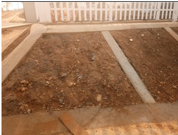
图 1-10 施工场地边坡施工现状 (2017年11月)
