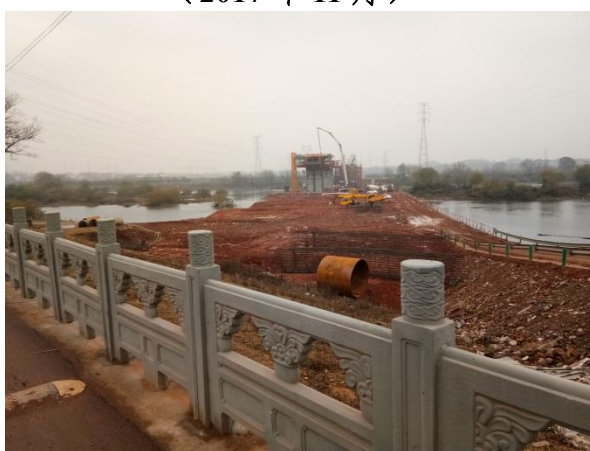
图 1-12 坑西特大桥施工现状 (2017年12月)
