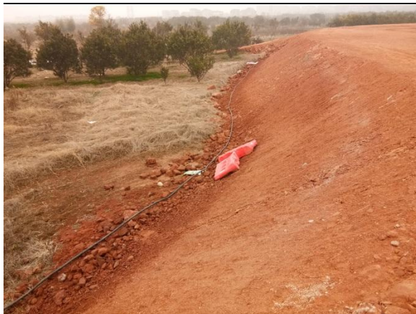
图 1-16 主线路基边坡施工现状 (2018 年 2 月)
