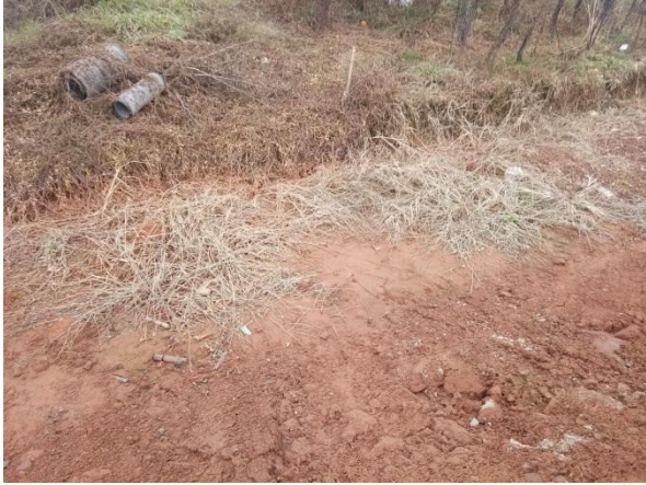
图 7 路基两侧临时排水沟
