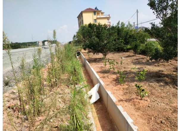
图 8 路基两侧排水沟
