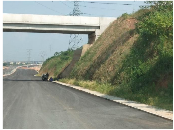
图 10 路堑边坡绿化及坡脚边沟
