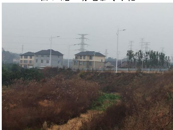
图 5 路堤边坡绿化
