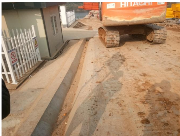
图 1-8 施工场地临时排水沟（2017.10）
