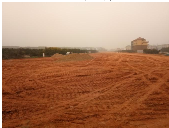
图 1-15 主线终点处施工现状 (2018年1月)
