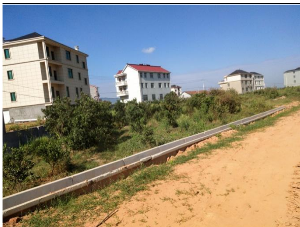
图 1-28 主线路基两侧预设 U 型排水沟施工现状（2018.8）
