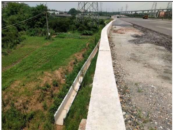
图 1-54 主线路基工程现状 (2019.9)
