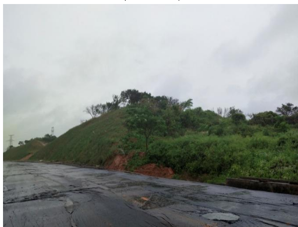
图 1-49 路堑边坡绿化施工现状 (2019.6)
