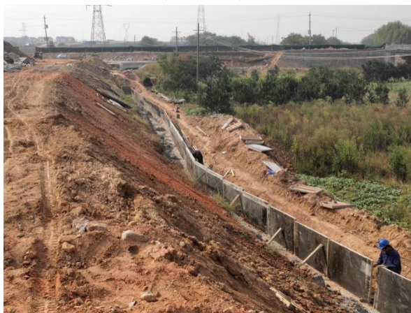
图 1-32 主线路基两侧挡墙施工现状（2018.10）
