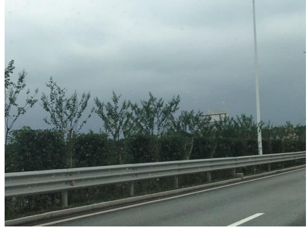
图 14 中央分隔带综合绿化
